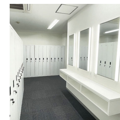
スタッフ更衣室を改修
